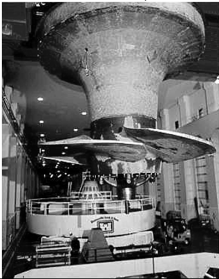
Oběžné kolo vertikální kašnové Kaplanovy turbíny 50 MW, Bonneville Dam, USA
