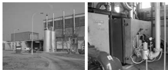
Energo centrum a kotelna
