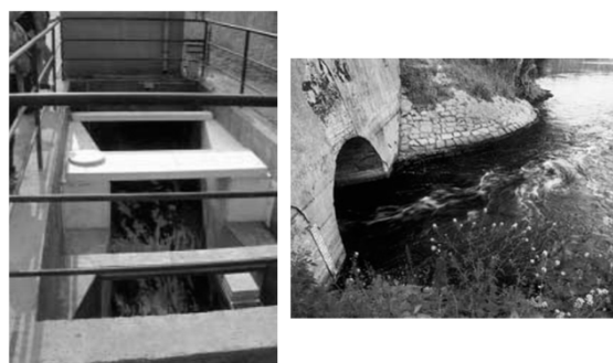
Měřící žlab a výtok vody do řeky
