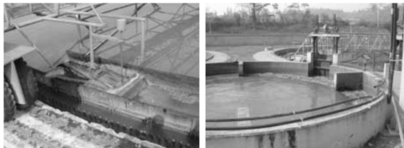
Odtok vody a kal z radiálního usazovače
