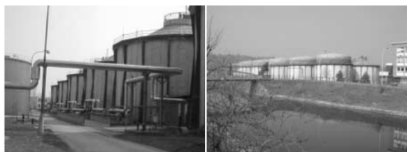
Produkce bioplynu Vyhnívací nádrže s plynojemem
