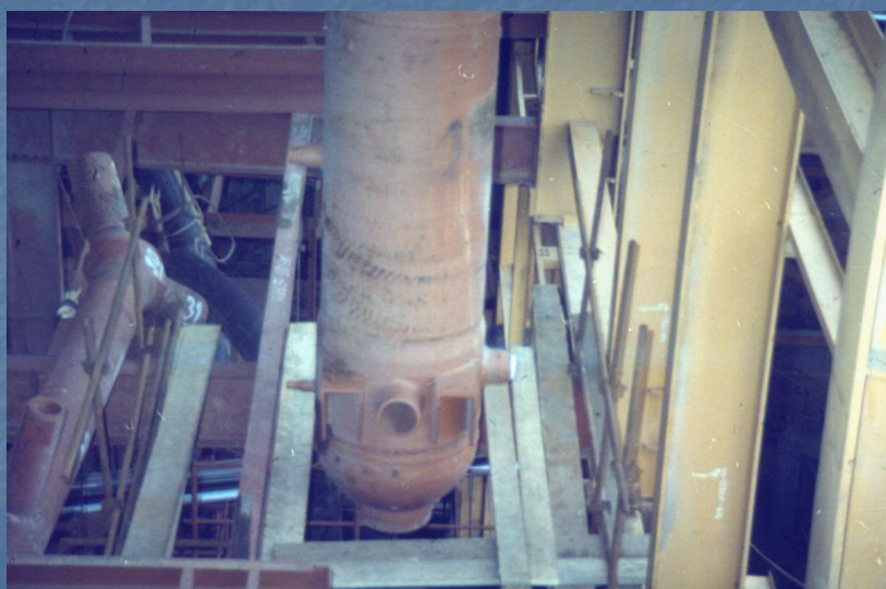
Cyklonový separátor vlhkosti na konci výparníku
