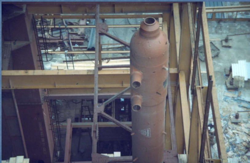
Cyklonový separátor vlhkosti na konci výparníku
