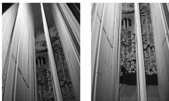
Zanesený výstupní přehřívák
