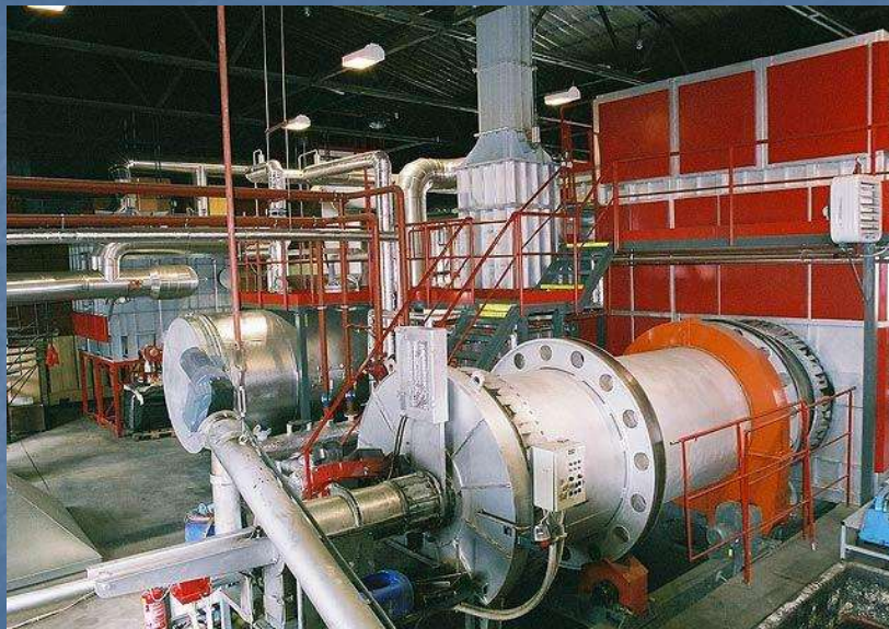
Rotační pec na spalování průmyslového odpadu
