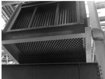
1 – trubkovnice, 2 – trubky, 3 – stěna tahu, 4 – obrátové přepážky
